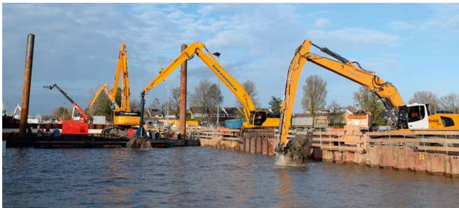
◉ Volle bakken klei naar boven halen vraagt veel van de machine. Op de achtergrond de Etec 849-II met speciale gripper en op ponton nog een Etec 859-III van Gerard Bos.
