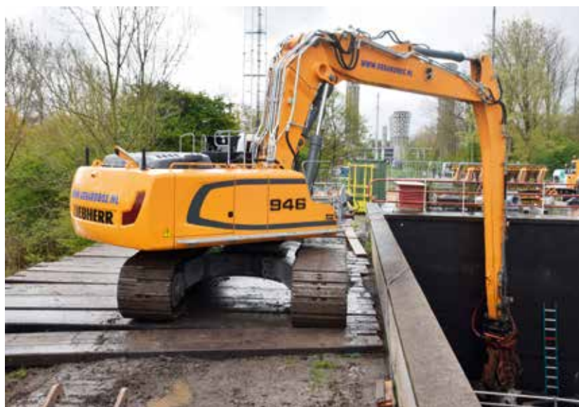
◉ Liebherr R946 SHD met NPK SV-24 XCR betonschaar tijdens sloopwerk aan de Velsertunnel.
